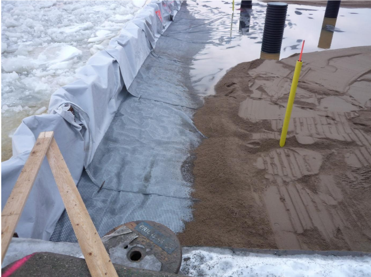
Figur 35. Foto visande geotextil, jordarmeringsnät samt sandfyllningen. Observera att geotextilen ligger vinkelrät sponten medans jordarmeringsnätet ligger längs spontlinjen. Fotot taget den 3/2-2011. Foto Kalle Mattson, Peab.
