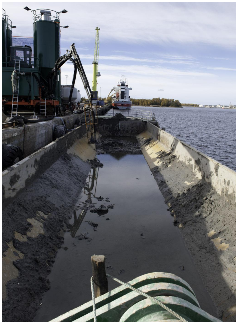
Figur 25. Foto visande pråm för transport av muddermassor till Kaj. Foto Per Lindh.
