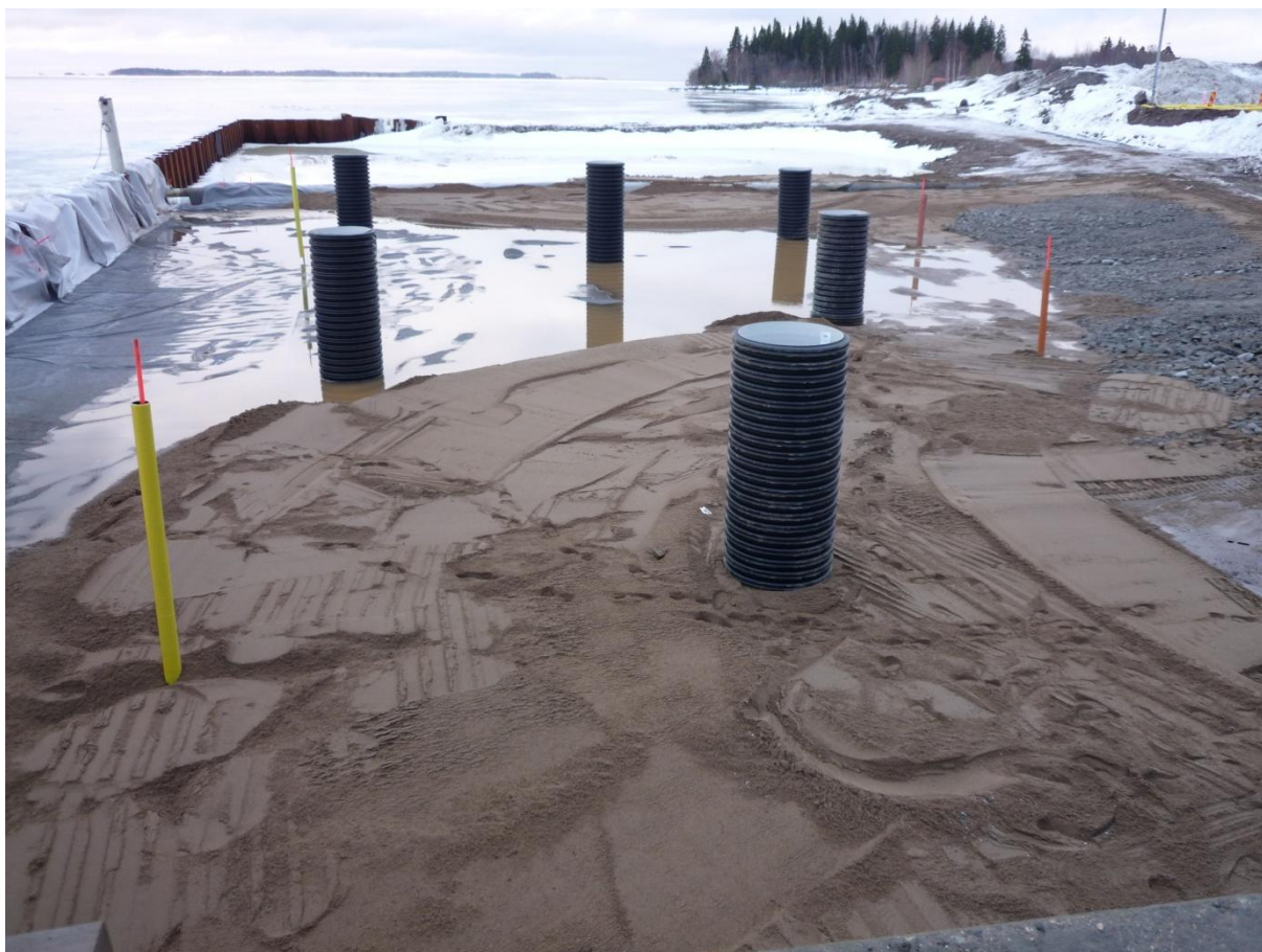
Figur 19. Foto visande påförandet av fiberduk, jordarmeringsnät, grus och krossmaterial. Foto Karl Mattson, Peab.
