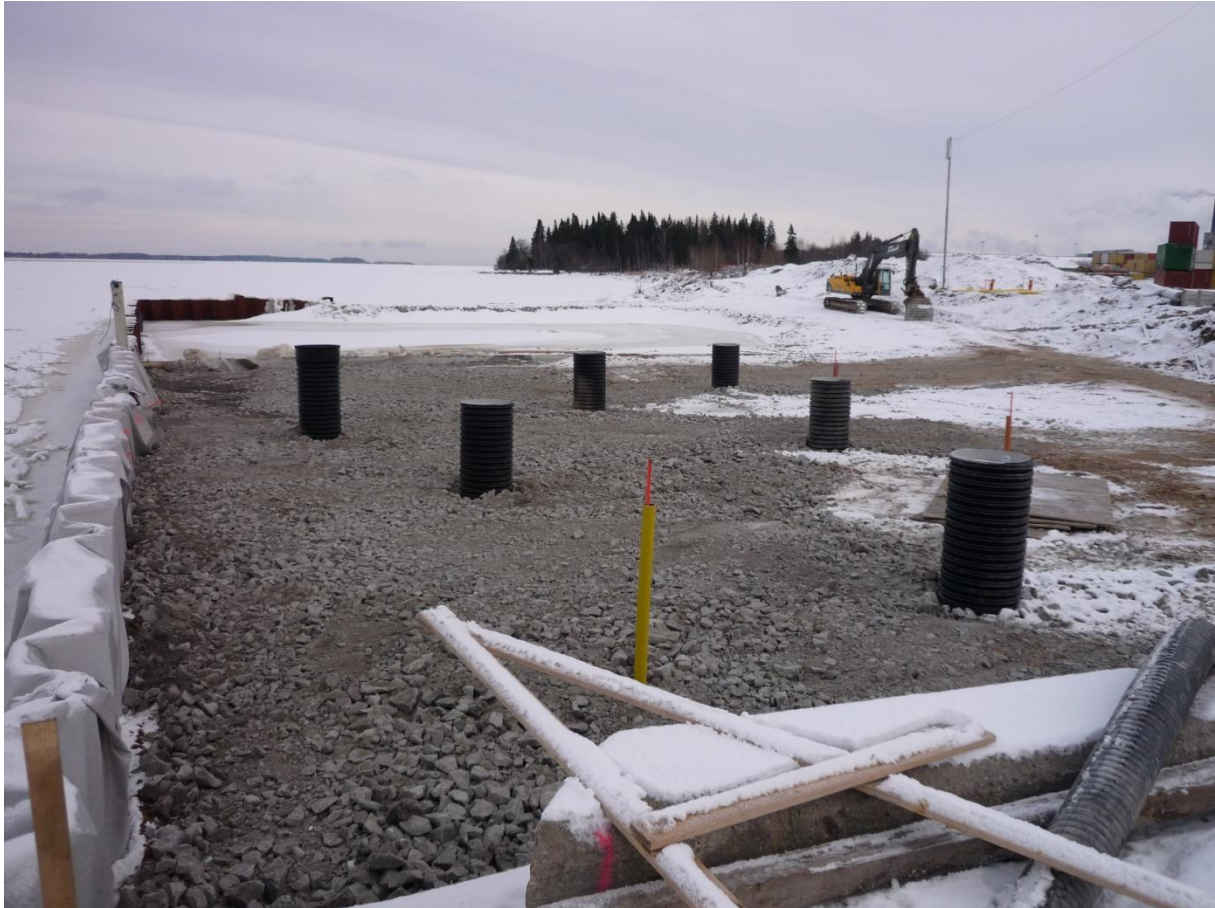
Figur 36. Foto visande sprängstensfyllning, peglar och provtagningsbrunnar. Fotot är taget den 7/2 -2011. Foto Karl Mattson, Peab.
